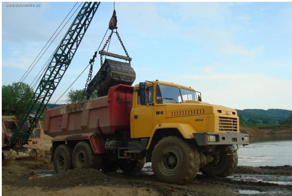
Рисунок 2.6 – КрАЗ-65032 на будівництві
