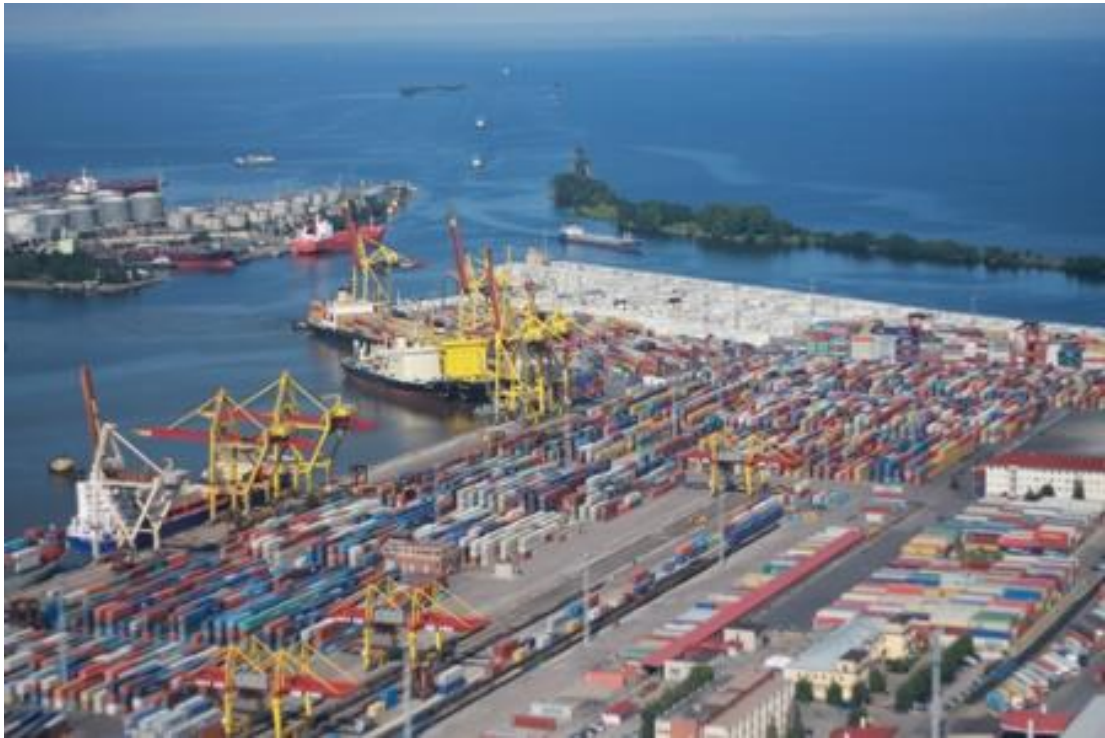
Рис. 3.4.1. Фото роботи Морського перевантажувального Терміналу
