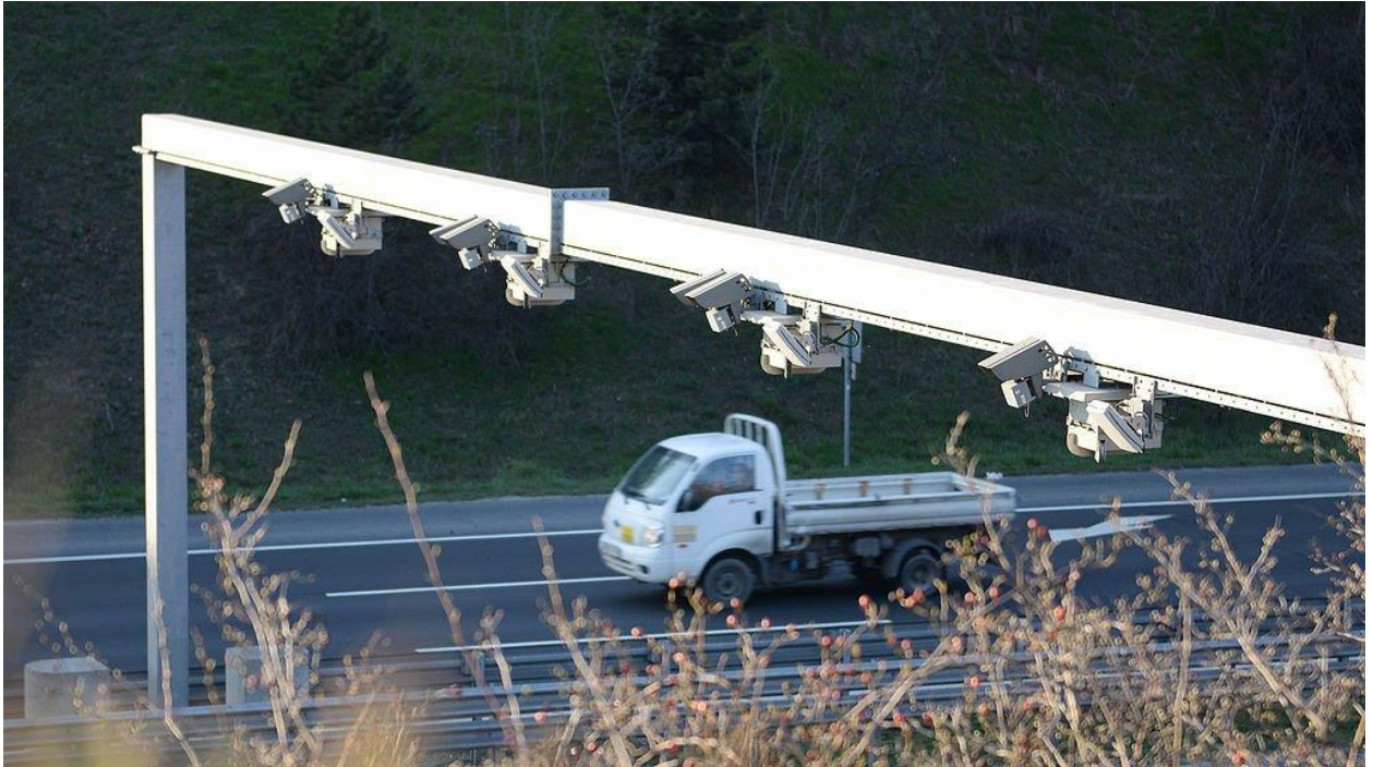
Рисунок 2.1 – Демонстрація система зондування та моніторингу, встановлена на точці виявлення для спостереження за рухом транспортних засобів і збору даних[7]
