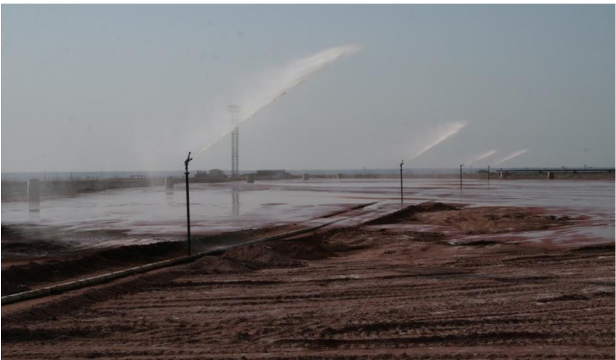
Рис. 3. Модернізована стаціонарна сплінкерна система пилопригнічення
