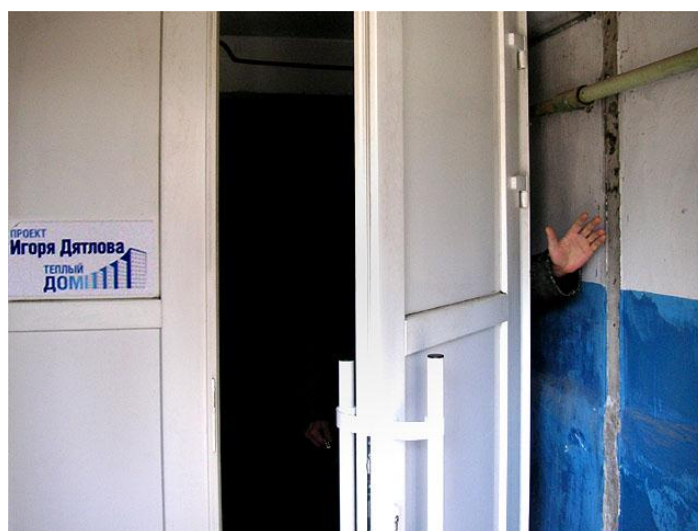
Рис. 5. Приклад виконання «утеплення» дверного блоку під'їзду
