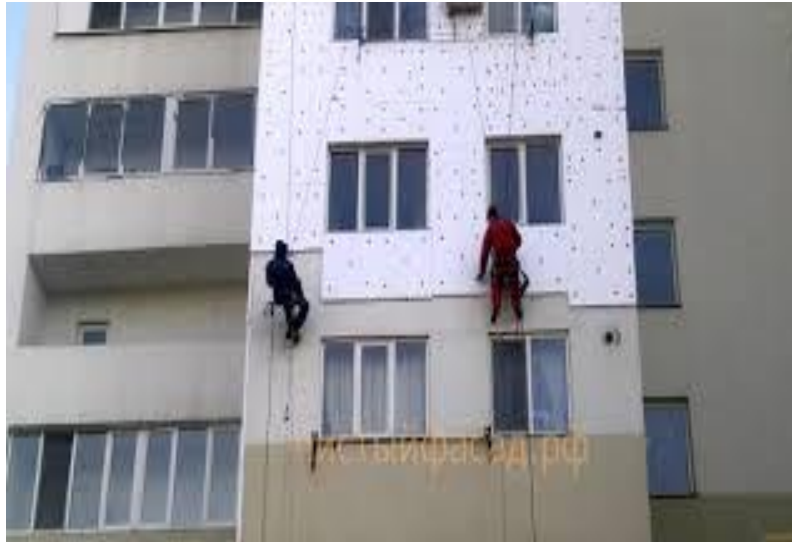
Рис. 6. Виконання утеплювальних робіт у безопорному просторі
