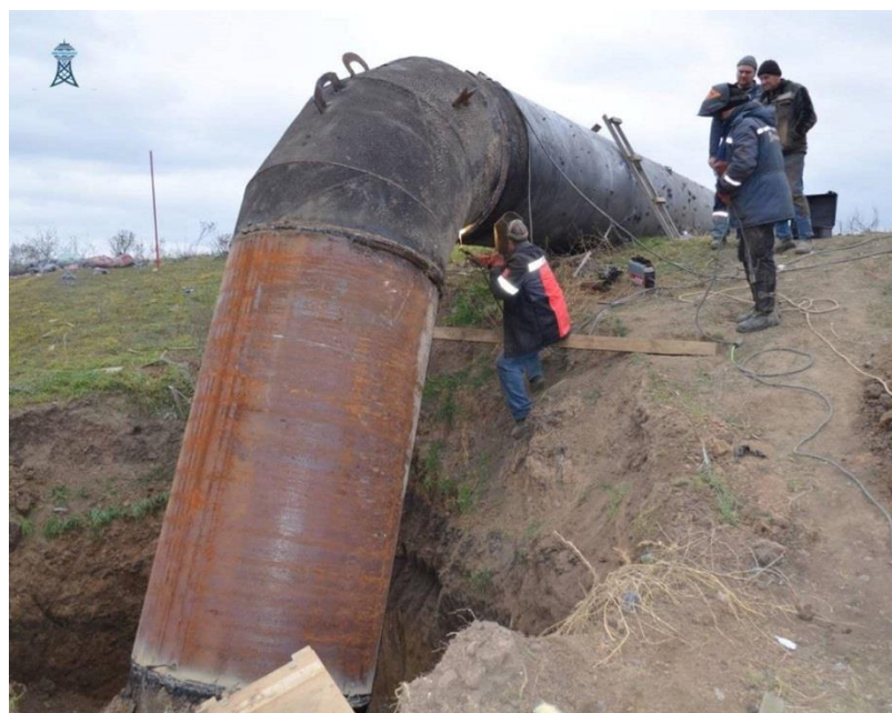
Рис. 1.4. Відновлення дніпровського водогону [30].
