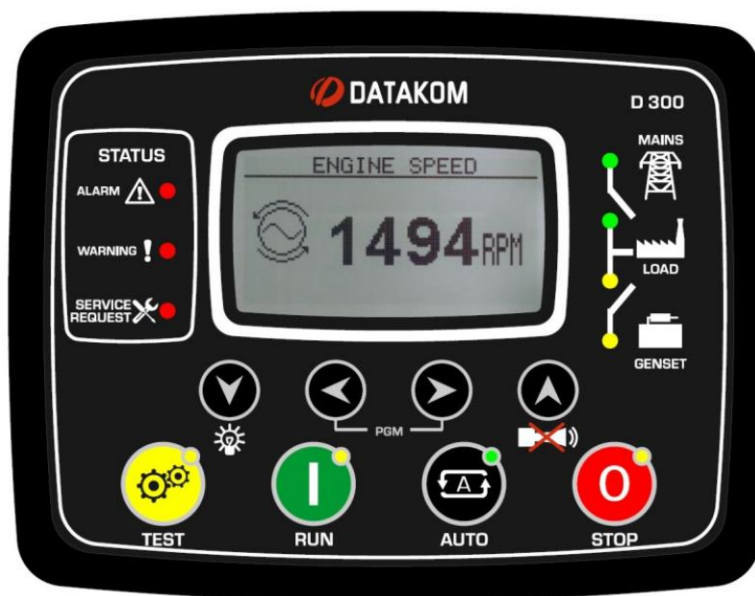
Рисунок 2.15 – Багатофункціональний контролер генератора із зарядним пристроєм [4]
