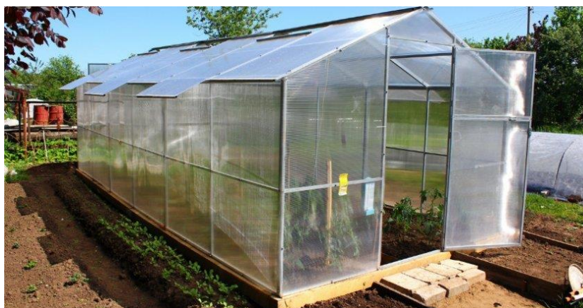
Рисунок 2.2 – Теплиця з плоским дахом
