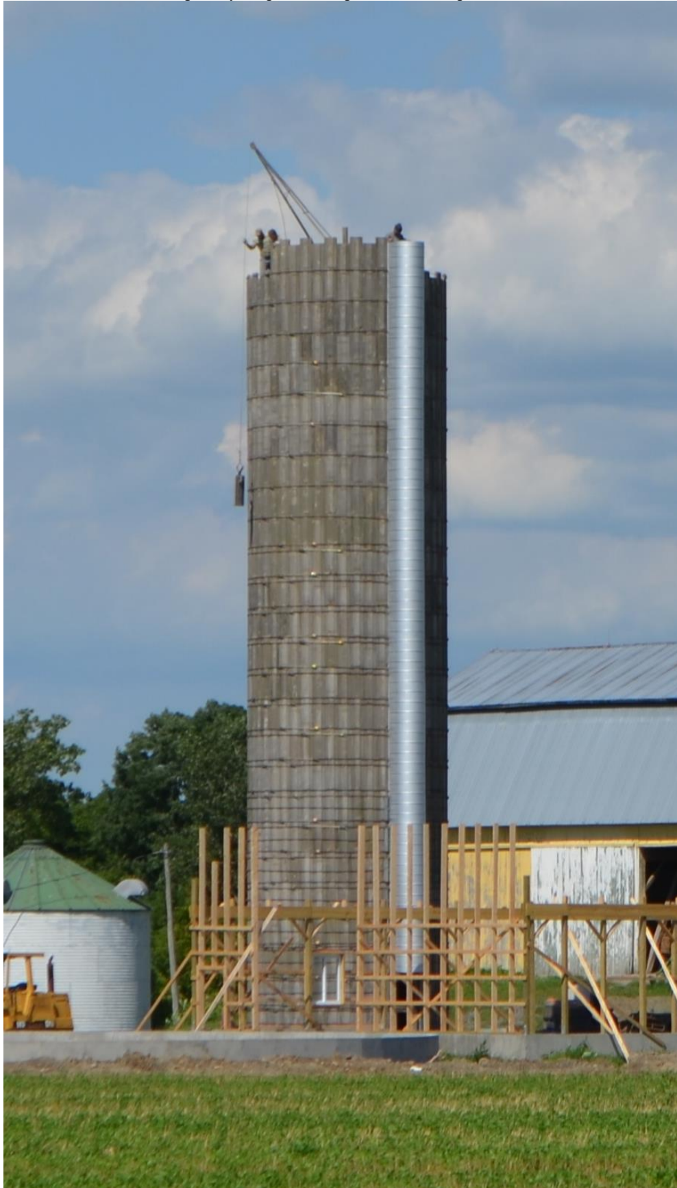
Рисунок 1.3 – Бетонний силос на стадії будівництва
