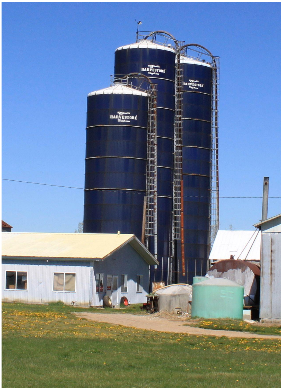
Рисунок 1.5 – Баштові силоси Harvestore з низьким вмістом кисню
