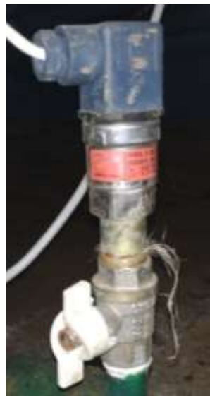
Рисунок 1.21 – Давач тиску для контролю тиску на виході насосних агрегатів
