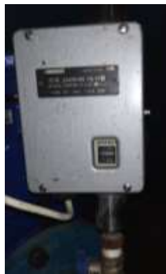
Рисунок 1.19 – Реле тиску РД-8Т (реле «сухого ходу»)
