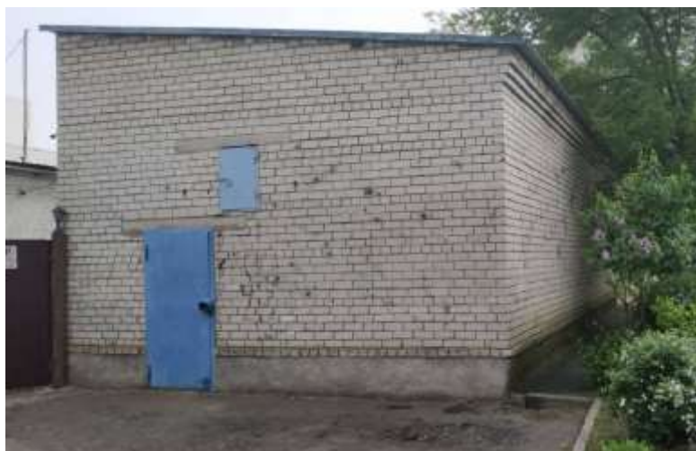
Рисунок 4.1 – Зовнішній вигляд будівлі насосної станції
