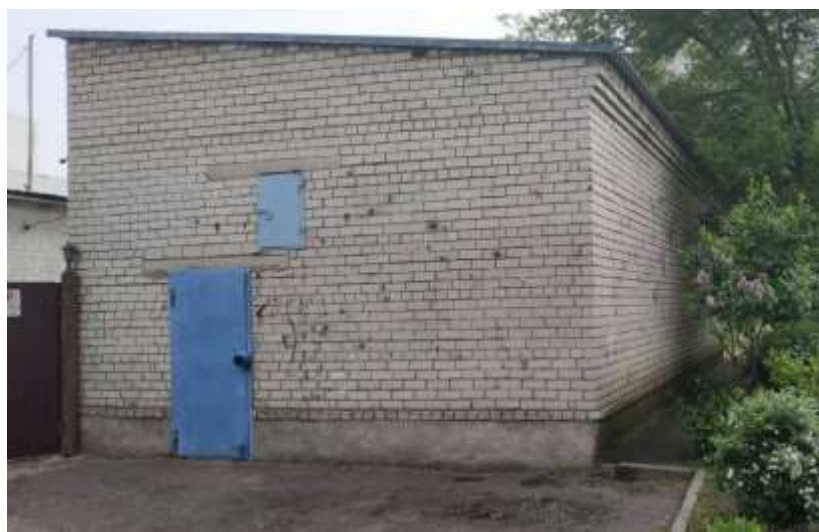
Рисунок 1.15 – Зовнішній вигляд будівлі насосної станції
