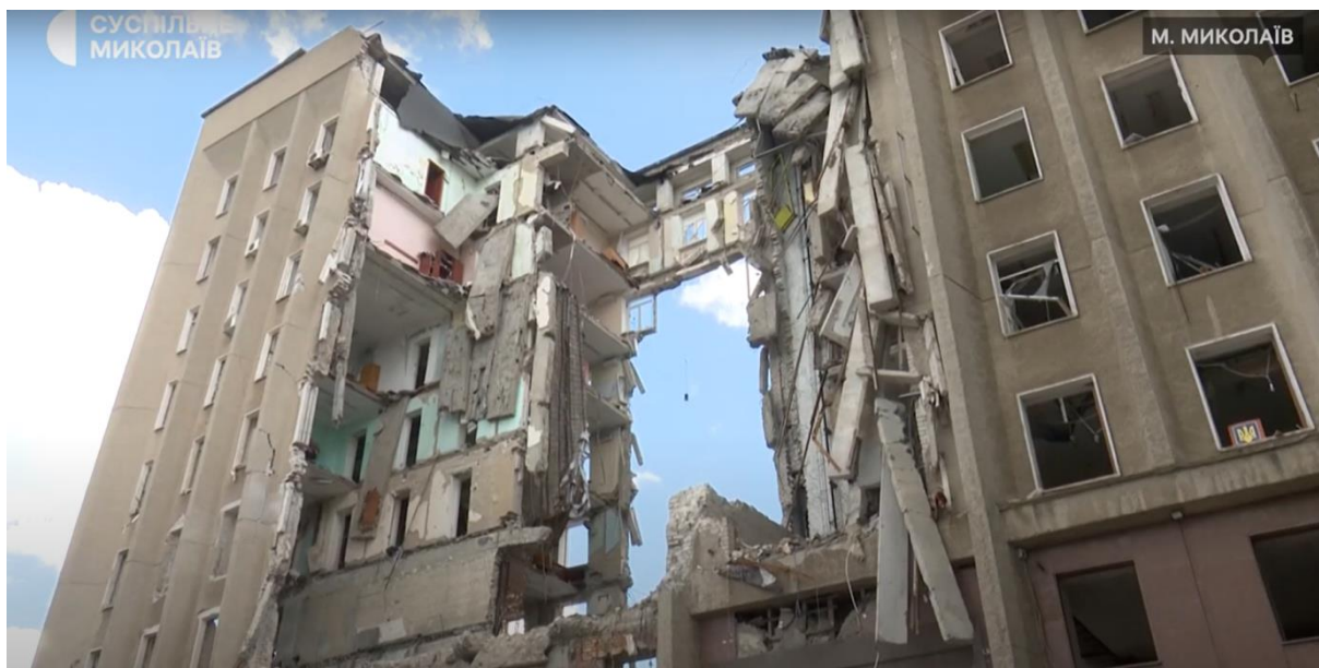
Скріншот відеоінтерв'ю з рятувальником, який розбирав завали у зруйнованій будівлі Миколаївської облради. Джерело: Youtube-канал Суспільне Миколаїв
