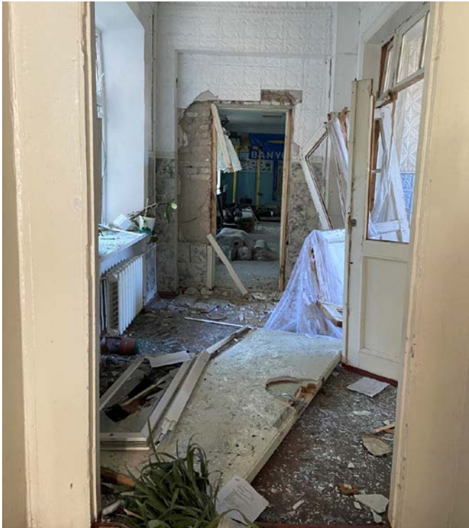
(Фото 1) Руйнування учбового корпусу
