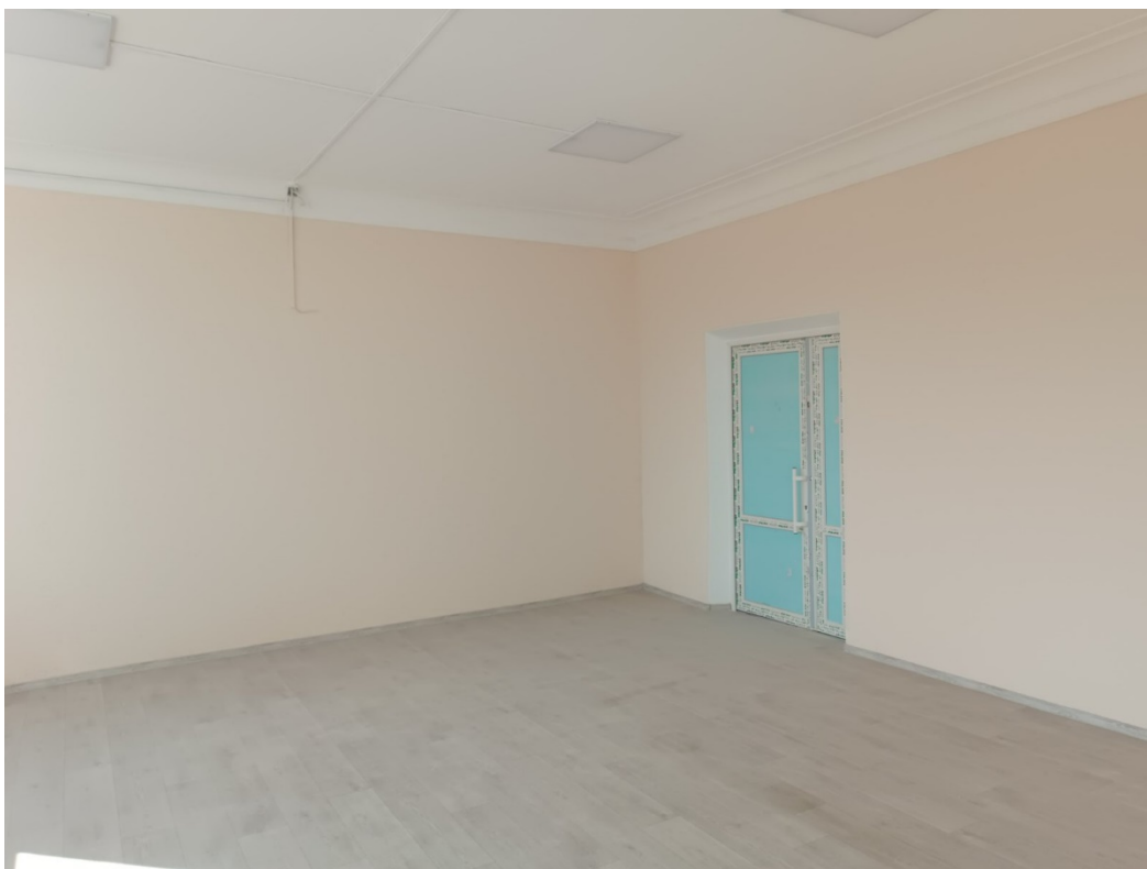
(фото 4) Відновлення учбового корпусу
