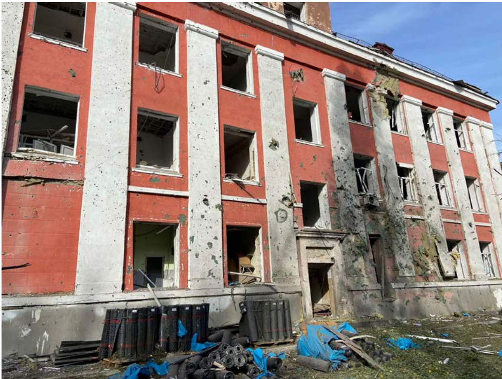
(фото 2) Руйнування учбового корпусу
