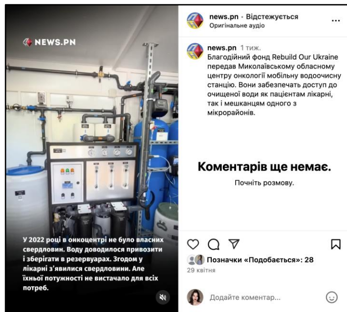
Рис. 3.12 Відео для соціальних мереж про встановлення водоочисних станцій
