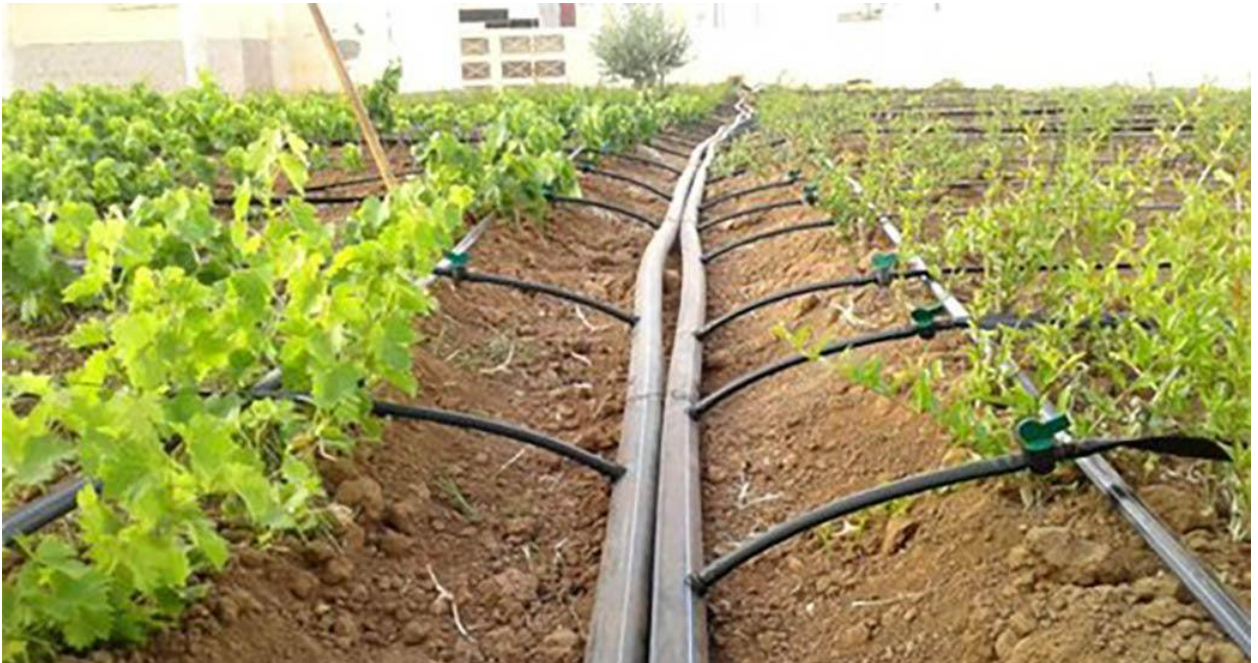
Рисунок 1.4 – Приклад системи мікрозрошення [6]
