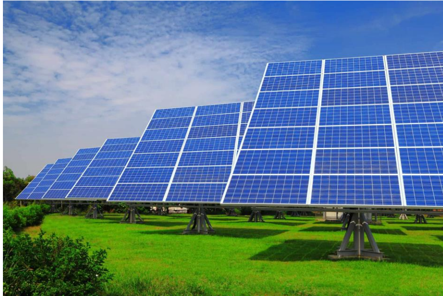
Рисунок 1.7 – Загальний вигляд сонячних панелей [7]
