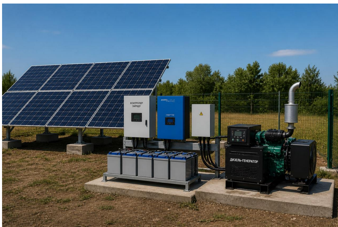
Рисунок 1.1 – Приклад реалізації гібридної енергетичної системи на базі дизель-генераторної установки та сонячної електростанції [1]
